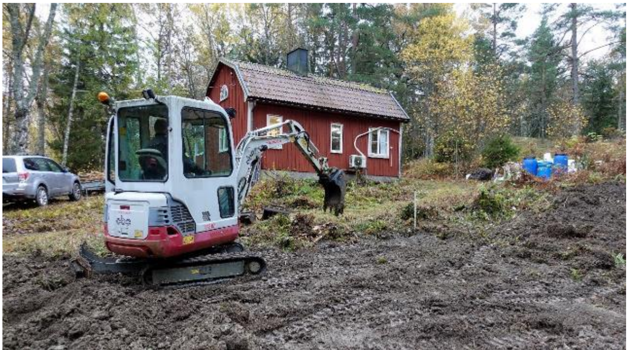
Här iordningställes en yta för att kunna bygga en ny uteplats.
